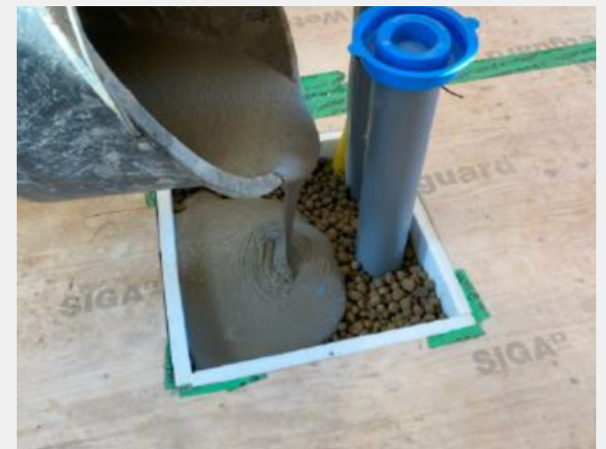
Kopplingsgrop som gjuts i betong. (Klara byggsystem, 2024)
